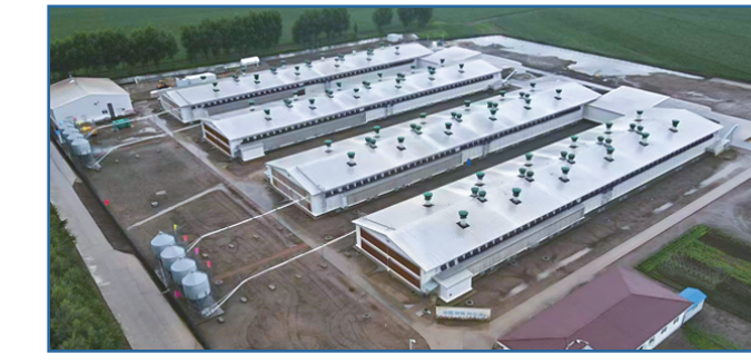
吉林榆树33万只肉鸡笼养项目 Jilin Yushu 330,000 Broiler Cage Rearing Project
